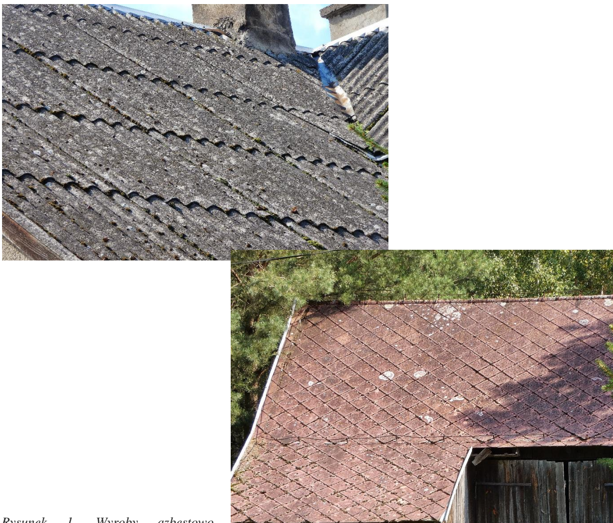
Rysunek 1. Wyroby azbestowo-cementowe: na górze z lewej- płyty faliste, na dole po prawej- płyty płaskie (źródło: materiały własne).
